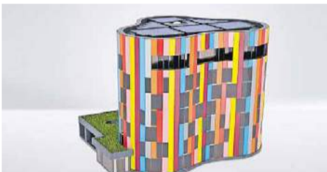
Von der Planung und Modellkonstruktion... Die Architektur des Gebäudes stammt von ELEMENTAR Studio für Architektur und Transformation aus Wuppertal.
